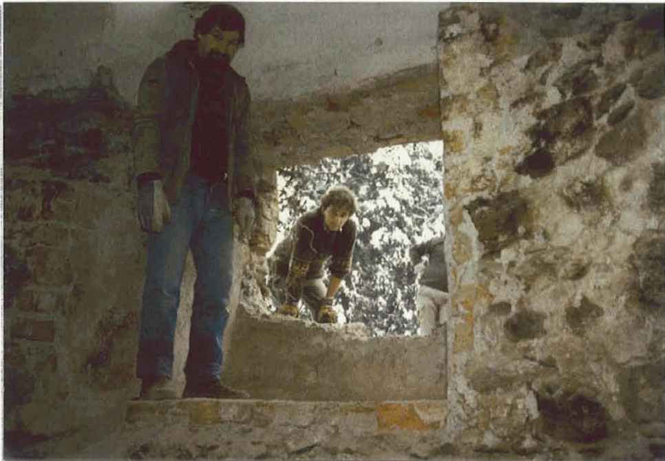
Turm-Renovierung, Hans-Peter Maier und Gerd Hoch, Abbrucharbeiten im Februar '87
