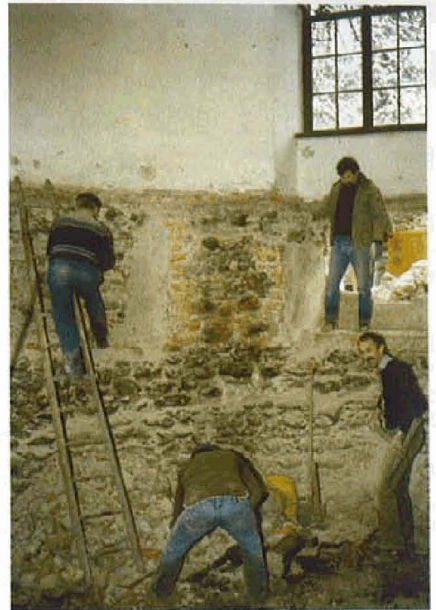
Steinbrucharbeiten im Turm '87
