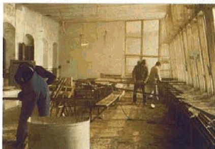
Pfosten werden entrostet '81
