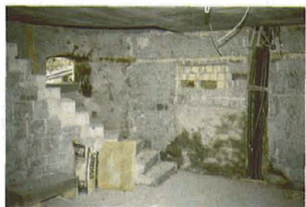
Rohbau Kellergeschoss Turm '87
